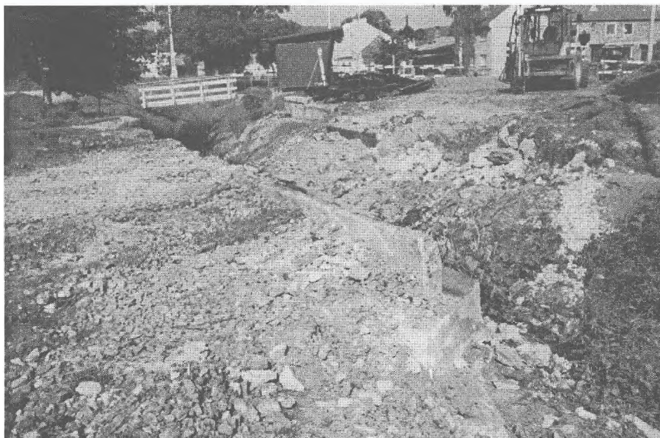
Zahájení výstavby trebčínského mostu
