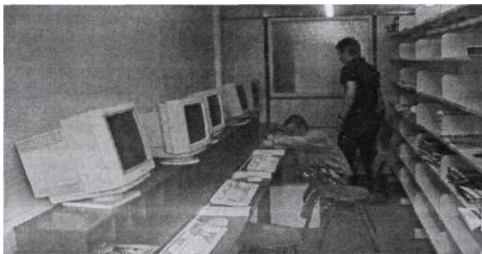
Dokončování instalace PC sítě (foto L. Porteš)
