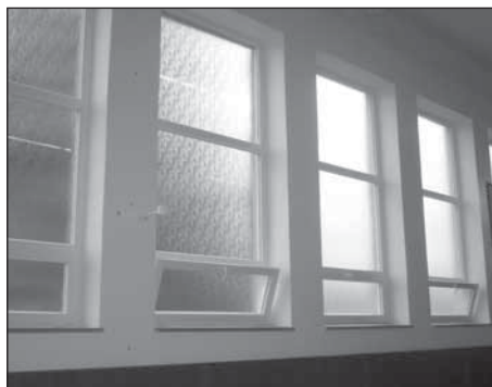
Nová plastová okna v tělocvičně
