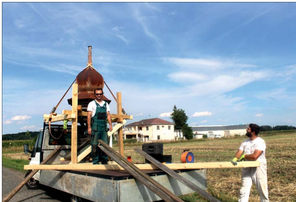
Mgr. Jiří Pokorný odváží věž kapličky k opravě.
