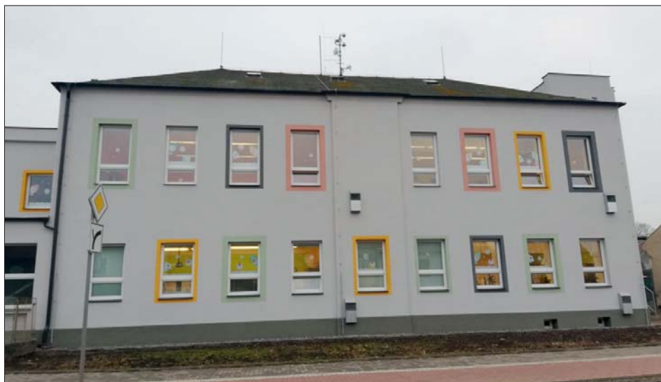
Pohled na starší budovu školy ze Školní ulice.
