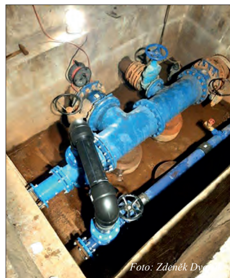
Armaturní šachta vodního zdroje Trávníky.
