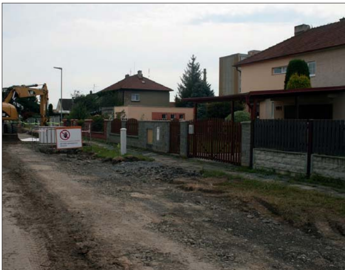
Stejný pohled na pravou stranu „Růžovky“.
