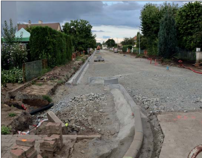
Práce pokračují - pohled od „rotundy“.
