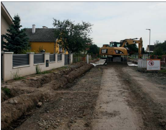
Pohled od křižovatky - levá strana ulice před rekonstrukcí...
