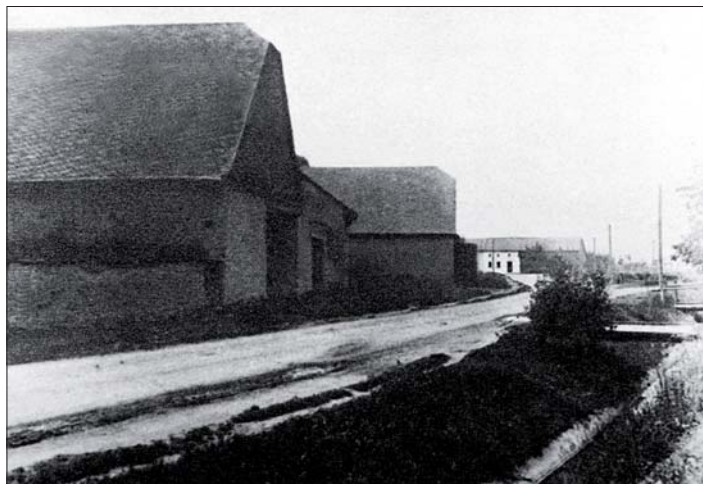
Část Školní ulice směrem k Záhumení.
