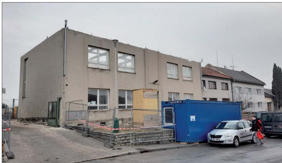
Rekonstrukce školy začala od střešky.
