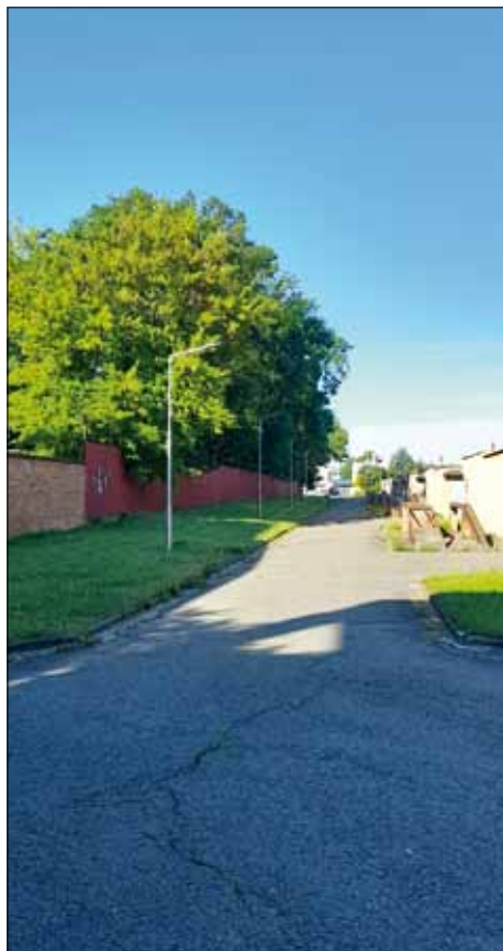
Nové veřejné osvětlení u garáží v Lutíně.
