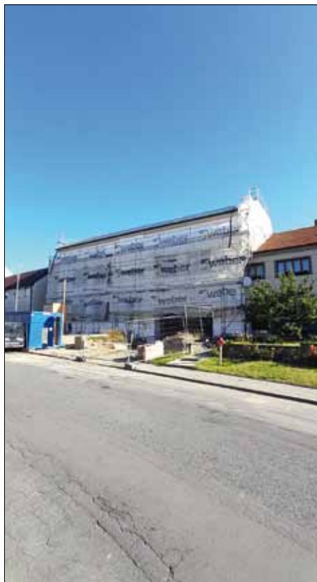
Závěr se blíží (zateplování a nová fasáda hasičské zbrojnice v Třebčíně).
