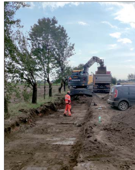
S budováním cyklostezky do Luběnic jsme začali na začátku září, práce už výrazně pokročily. Foto: J. Chrást
